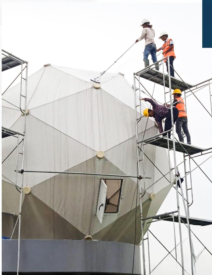
**B**anten - Pada tanggal 03 Februari 2024 Tim DTP resmi memulai kegiatan *Biannual Maintenance* pada SNP#38 Eutelsat OneWeb x DTP. Pemeliharaan ini bertujuan untuk memastikan kinerja antena tetap optimal dengan melakukan penambahan *grease* pada *gearbox* serta *cleaning radome* secara berkala.
